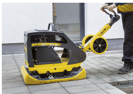
Aucune rupture des pavés
