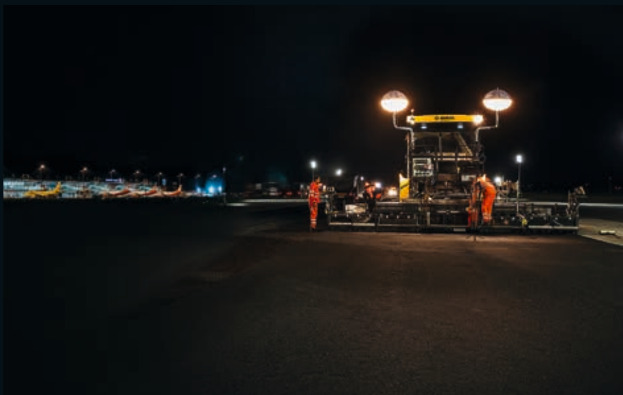
Chantier nocturne d'un aéroport : les meilleurs résultats dans un temps record.
