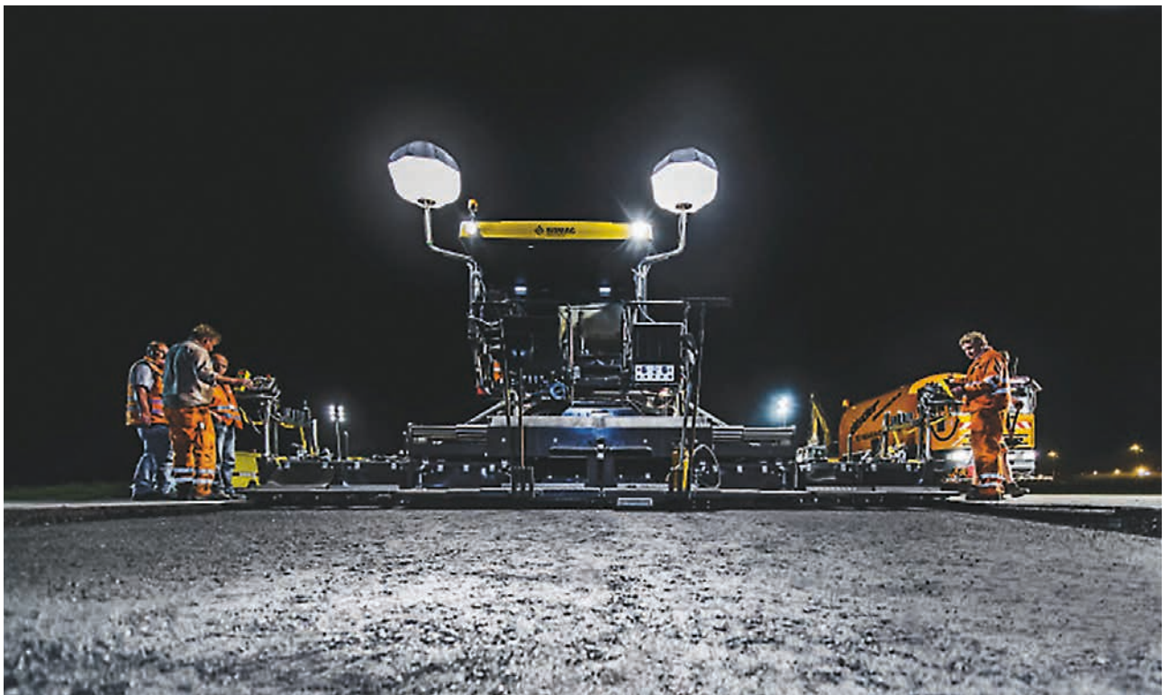
Perfekte Ebenheit als Arbeitsergebnis – gerade auch unter Zeitdruck wie hier auf einer Nachtbaustelle am Flughafen.
