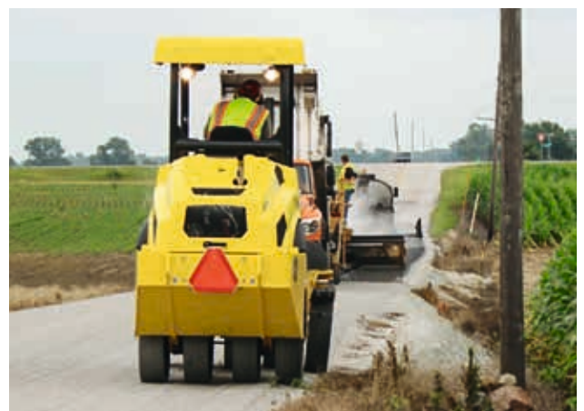
Die maximale Geschwindigkeit beträgt bis zu 20 km/h. Damit sind große Flächenleistungen möglich.
