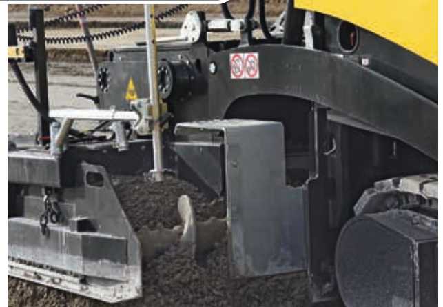
Einbau einer 30 cm dicken hydraulisch gebundenen Tragschicht; gemessene Vorverdichtung bis zu 90,8% Proctordichte.
