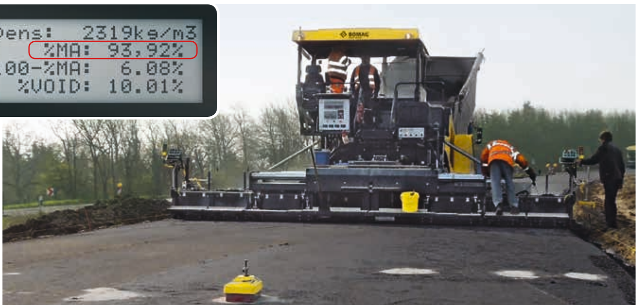
Asphaltbinderschicht AC 16 BS, 4 cm auf einer Breite von 8,0 m; gemessene Vorverdichtung bis zu 93,92% Marshall-Dichte.
