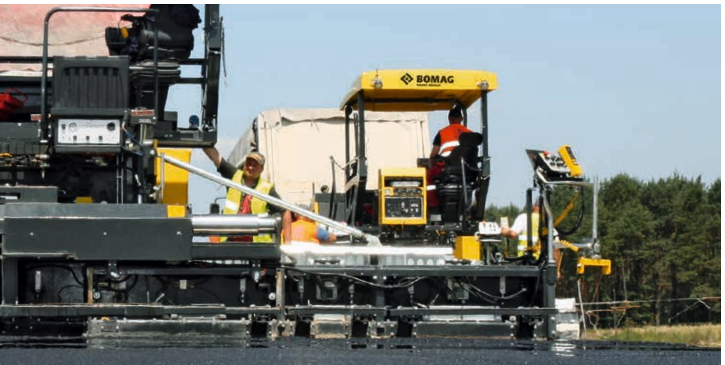
Contrôle automatique garantissant une parfaite planéité. Système Load-Control (L.C.S.) de BOMAG.
