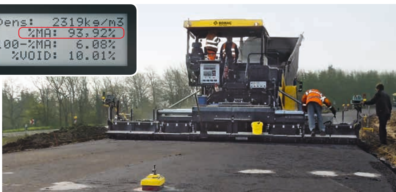
Couche de liant bitumeux AC 16 BS, 4 cm sur une largeur de 8,0 m, précompactage mesuré jusqu'à 93,92% de densité Marshall.
