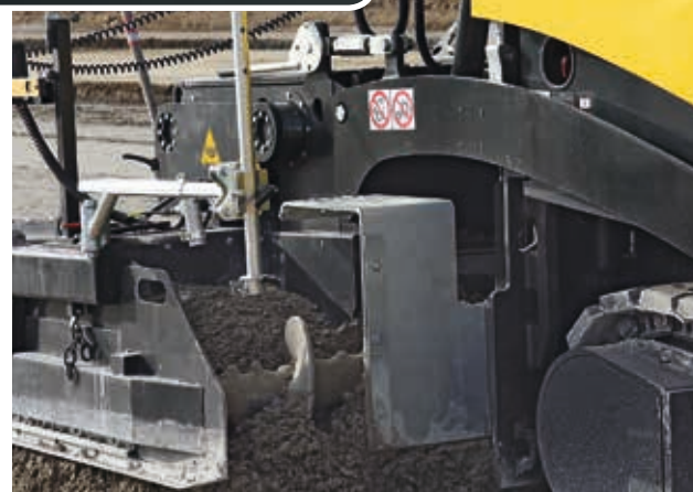
Pose d'une couche de base à liaison hydraulique de 30 cm d'épaisseur, précompactage mesuré jusqu'à 90,8% de densité Proctor.
